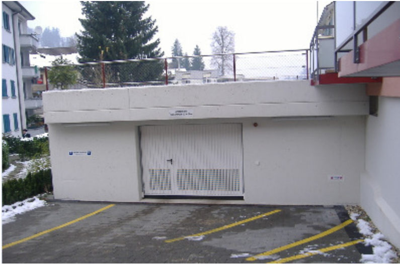
Adsystemische Garage. Sagenmattrain 3, 6003 Luzern
