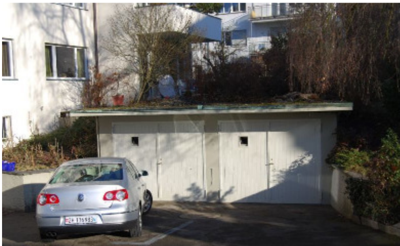
Extrasystemische Garage. Voltastr. 81, 8032 Zürich (1954)
